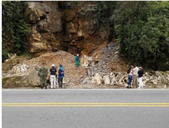
PUNTO 2 se observan bloques de material separado para la venta y taludes de 2 a 6 metros de altura en contrapendiente, también se observa obstrucción a las cunetas de las vías. Coordenadas al sistema MAGNA-SIRGAS Lat: 7.06709°N Lon: 75.44762°W
