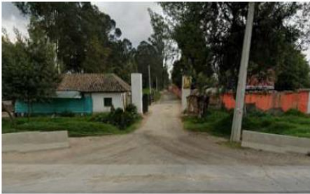
Conexión No 2 con la vía Funza – Mosquera. Acceso a las vías existentes internas de los propietarios de predios colindantes de la ALO.
