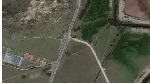
Imagen de la conexión de la vía “perimetral de Cerro Gordo” con la vía Funza-Mosquera - año 2016
