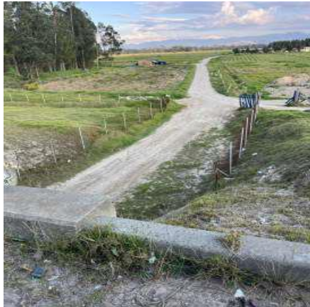
Imagen de pasaganado construido por el INVIAS para la comunicación de los dos globos de predio, pasando bajo la ALO Sur
