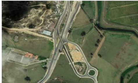
Imagen de la conexión de la vía “perimetral de Cerro Gordo” con la vía Funza-Mosquera - año 2019, donde se configuró un enlace a desnivel mediante construcción por parte del INVIAS
