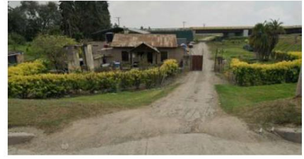
Conexión No 3 con la vía Funza – Mosquera. Acceso a las vías existentes internas de los propietarios de predios colindantes de la ALO.
