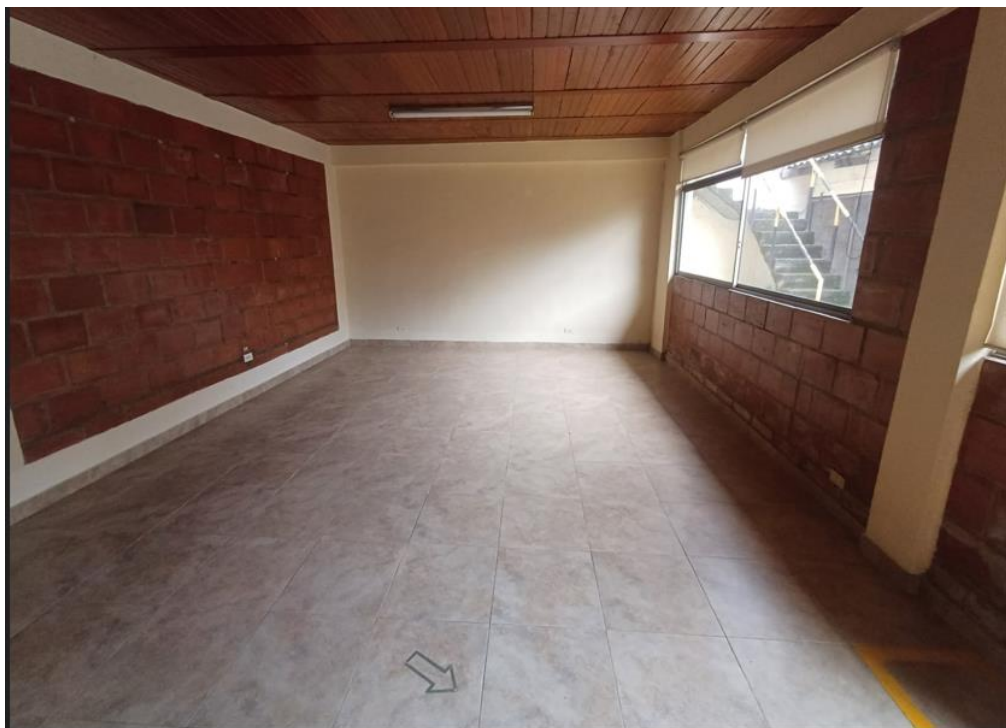
Imagen No. 9 tomada del acta de visita "Aula 3"
